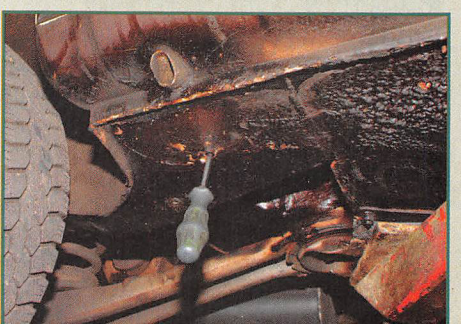
So sieht's aus, wenn (hier an der Hinterachse) das Reparaturblech schon wieder durch ist
